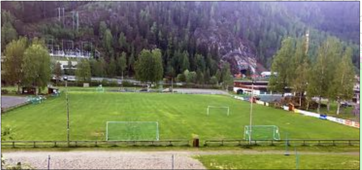
Fotballbanen må heves nesten 3 meter opp fra dagens nivå. Tunellpåsaget i bakgrunnen.
