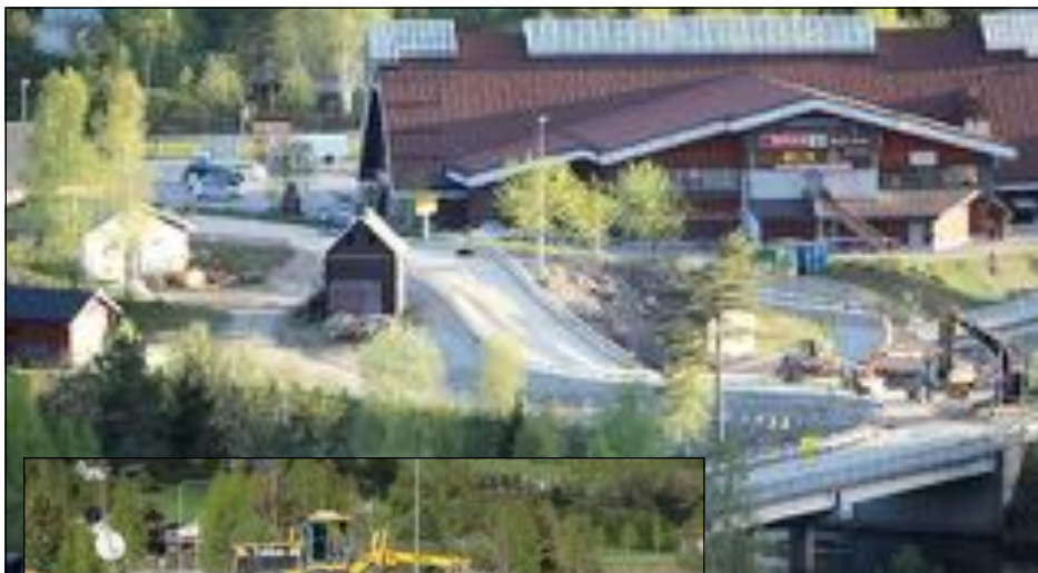
Midlertidig nytt løp for E16 og ny avkjøring til Østre Bagn blir laget.
