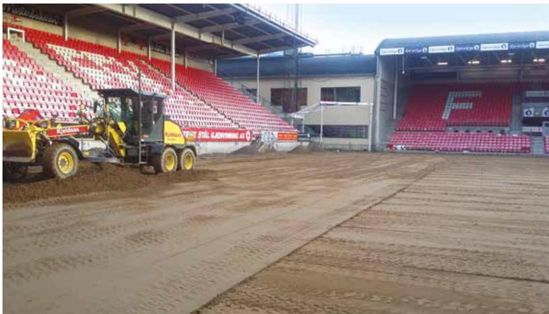
Avretting av topplag på Fredrikstad stadion
